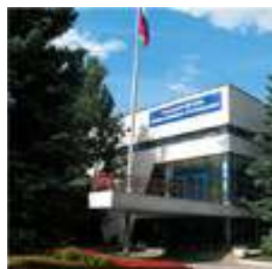
Административное здание Пристройка. Многофункциональный зал на 430
