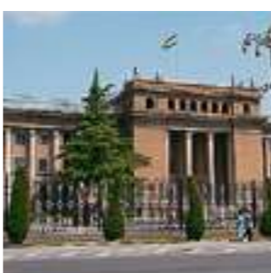
Правительственное учреждение Здания правительства, 4-ый блок
